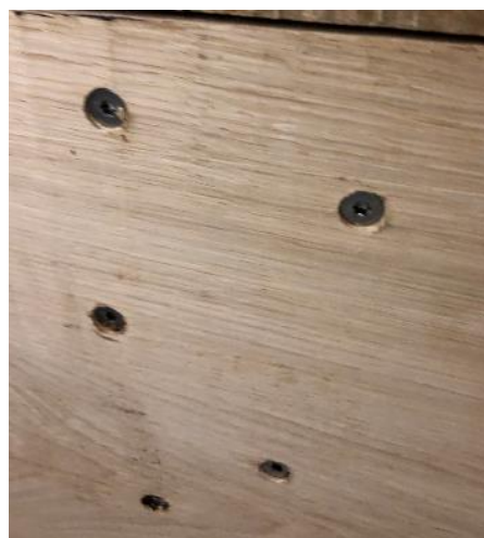
Planken worden verdiept vastgezet met schroeven in voorgeboorde gaten
