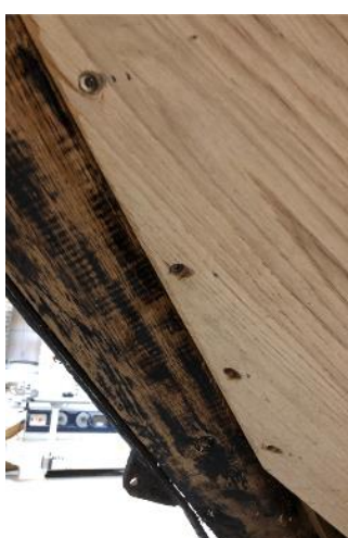
Planken worden verdiept vastgezet met schroeven in voorgeboorde gaten
