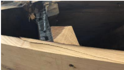
Scheur in zijkant van de plank
