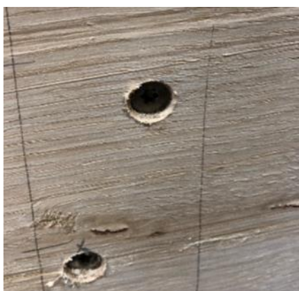
Schroefgaten verdiepen ivm epoxy plug
