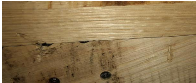
Oppervlakkige beschadiging (links), gespleten hout beschadiging (rechts).
