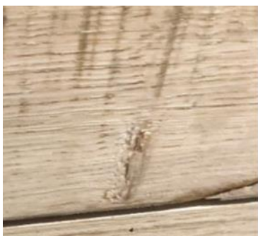
Oppervlakkige beschadiging (links), gespleten hout beschadiging (rechts).
