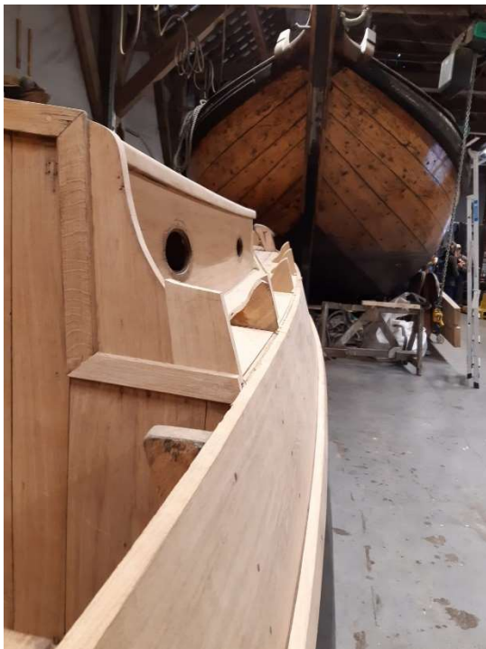
Bovenrand boeisel (ontbreekt nog) met de waterloos-gaten, gaten voldoende naar achteren aanbrengen zodat er geen water vlak voor het kajuitschotje met dek kan blijven staan.
