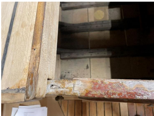
Scheur in bovenzijde kajuitdeur
