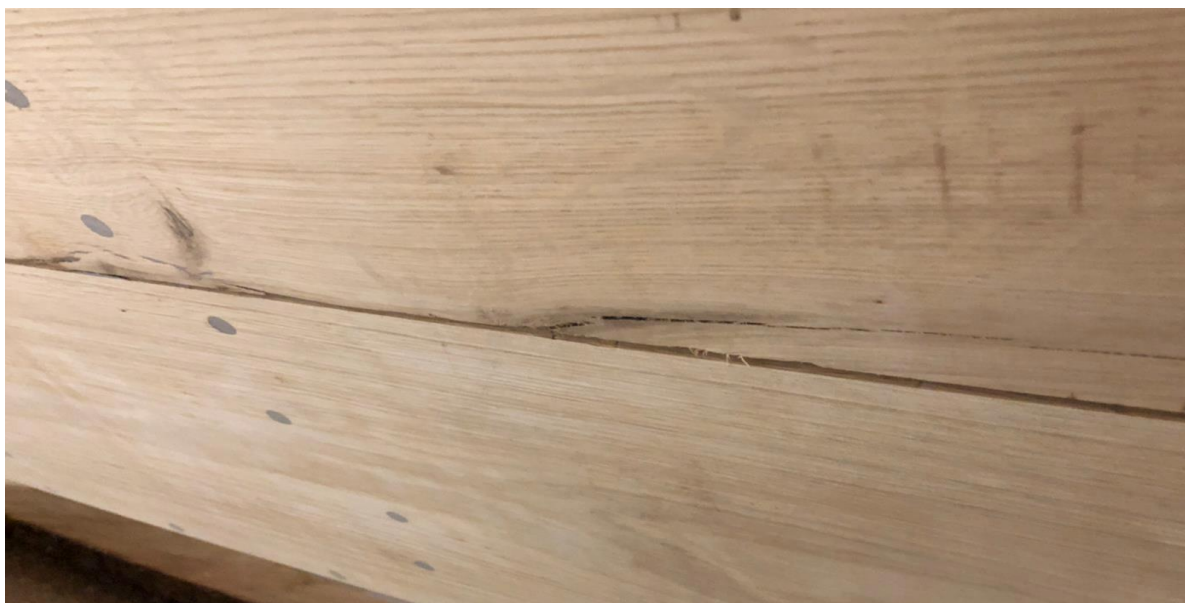
Knoesten: te verwijderen Scheuren: op te vullen met epoxy
